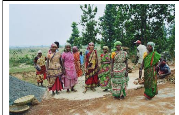
Schwere Arbeit im Straßenbau. Diese Frauen sind froh, ins Arbeitsbeschaffungsprogramm der Regierung aufgenommen worden zu sein.
