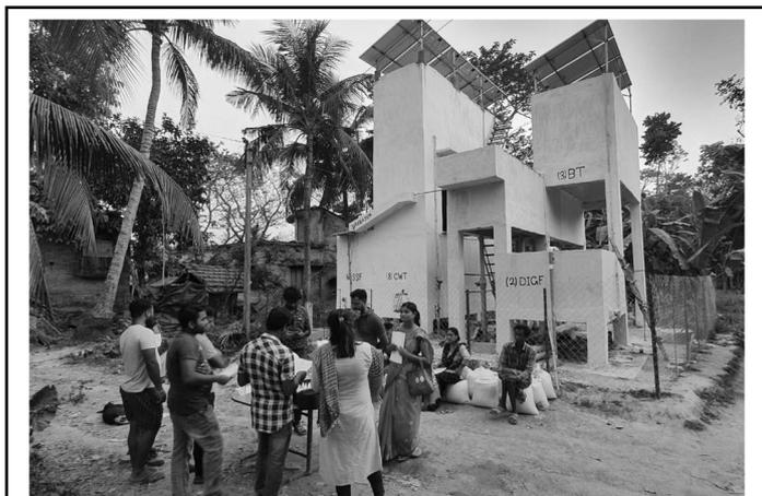
Fertiggestellte Trinkwasseraufbereitungsanlage in Rasui. Die Komponenten sind durch Abkürzungen kenntlich gemacht (SSF- Slow Sand Filter, CWT – Clear Water Tank, DIGF – Dynamic Intake Gravel Filter, BT – Buffer Tank. Nicht zu sehen/beschriftet: RSF – Rough Sand Filter, ACF – Activated Carbon Filter) © Indienhilfe
